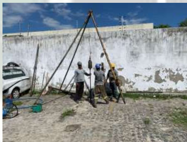
Foto 16 EXECUÇÃO DE SONDAGEM À PERCUSSÃO (SPT).
