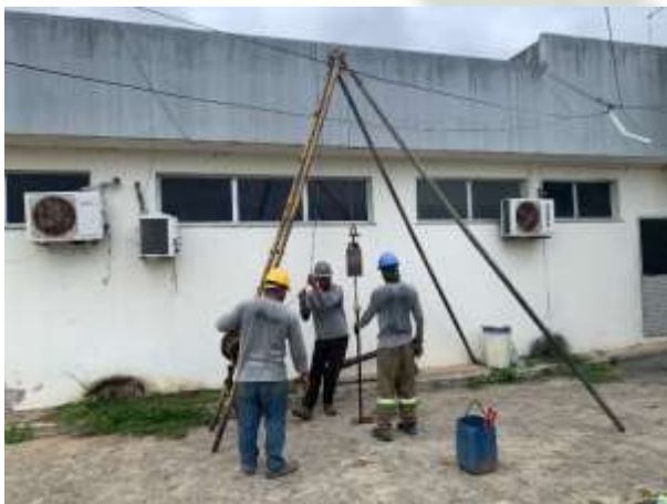
Foto 11 EXECUÇÃO DE SONDAGEM À PERCUSSÃO (SPT).
