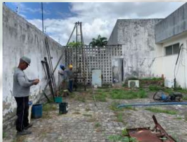
Foto 08 EXECUÇÃO DE SONDAGEM À PERCUSSÃO (SPT).
