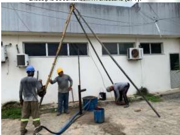
Foto 03 EXECUÇÃO DE SONDAGEM À PERCUSSÃO (SPT).
