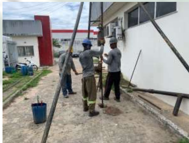
Foto 12 EXECUÇÃO DE SONDAGEM À PERCUSSÃO (SPT).
