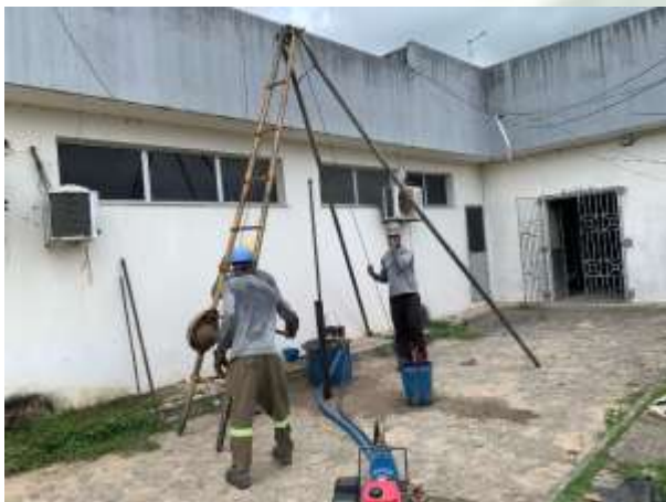
Foto 01 EXECUÇÃO DE SONDAGEM À PERCUSSÃO (SPT).
