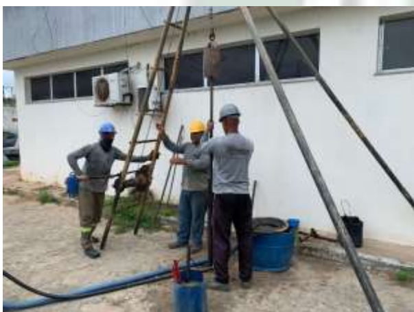
Foto 09 EXECUÇÃO DE SONDAGEM À PERCUSSÃO (SPT).
