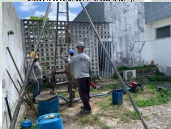
Foto 04 EXECUÇÃO DE SONDAGEM À PERCUSSÃO (SPT).
