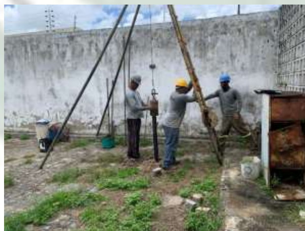
Foto 18 EXECUÇÃO DE SONDAGEM À PERCUSSÃO (SPT).
