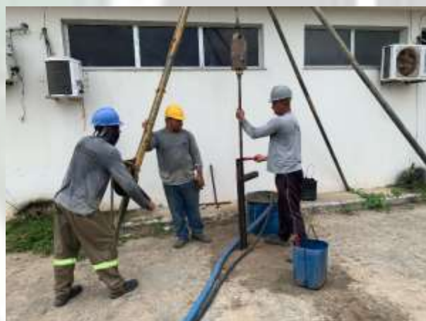
Foto 10 EXECUÇÃO DE SONDAGEM À PERCUSSÃO (SPT).
