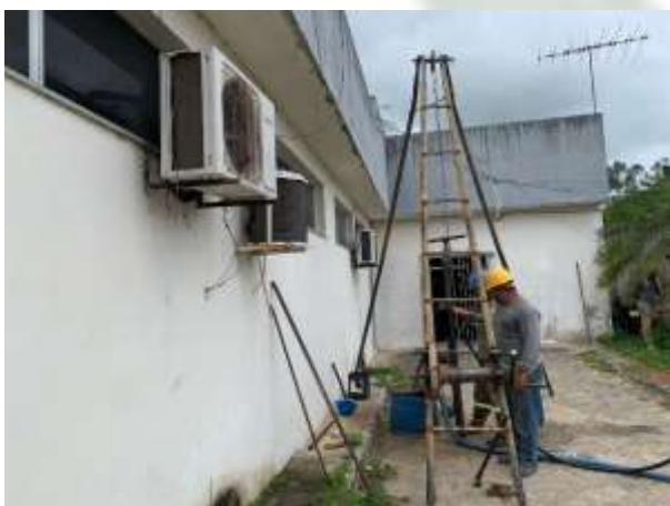
Foto 17 EXECUÇÃO DE SONDAGEM À PERCUSSÃO (SPT).
