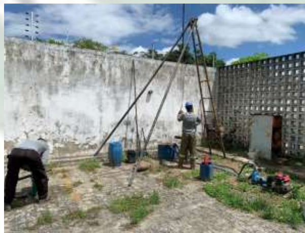
Foto 06 EXECUÇÃO DE SONDAGEM À PERCUSSÃO (SPT).
